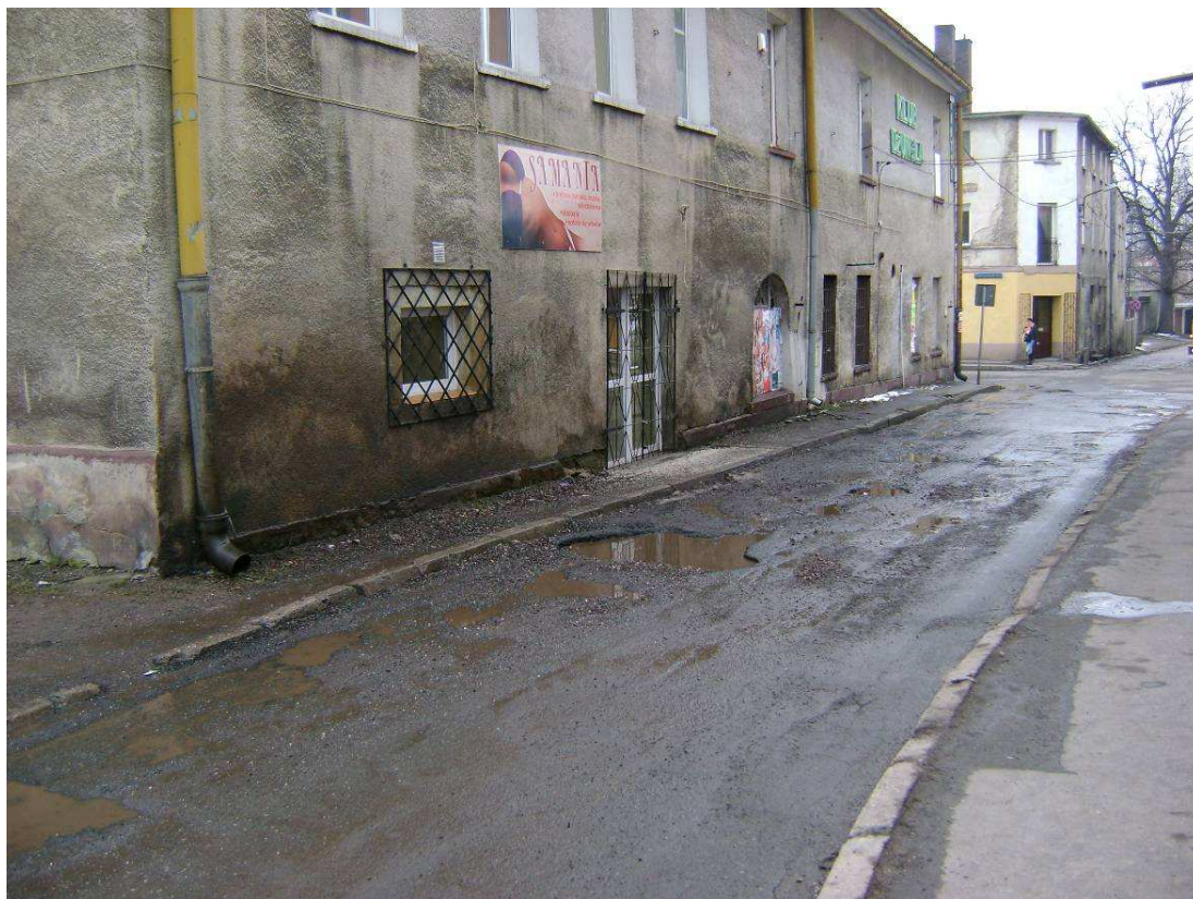
Fot.2 Przykład rynien wypuszczonych na chodnik
